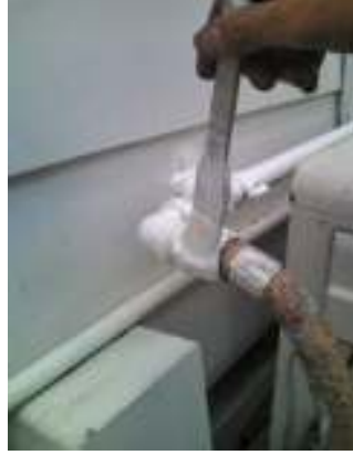
【ベランダ内壁 目地部シーリング・劣化剥離部パテ処理】
