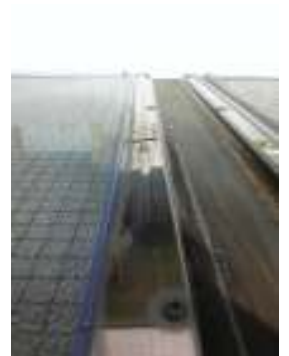
ガラス周り・枠周り
