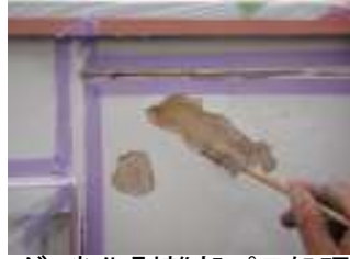
【ベランダ内壁 目地部シーリング・劣化剥離部パテ処理】
