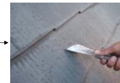
【浮き塗膜ケレン】
