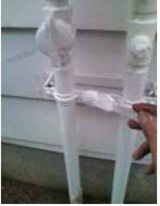
【外壁塗装前鉄部等の防錆処理】
