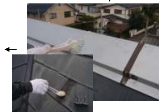
【板金部錆止め・雪止裏、下塗り】
