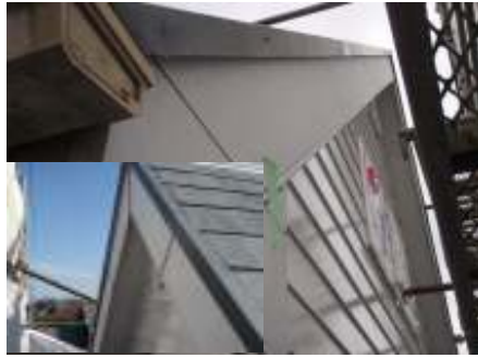
【窯業系破風材張り】
