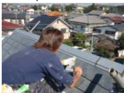
【接部・釘頭シーリング】
