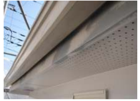
【破風板下塗(ファインプライマー)】
