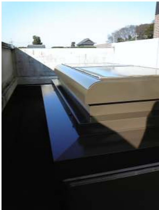
陸屋根内完了
