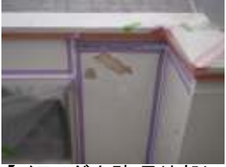
【ベランダ内壁 目地部シーリング・劣化剥離部パテ処理】
