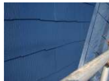
【補修塗装・完了】
