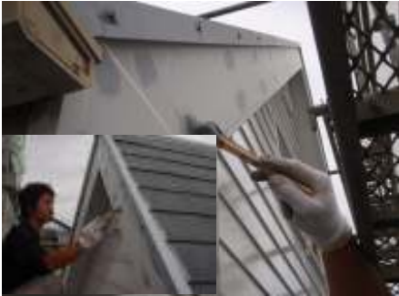
【釘頭 防錆処理】
