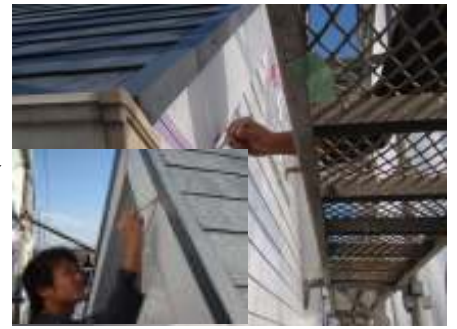
【目地部シールプライマ塗布】
